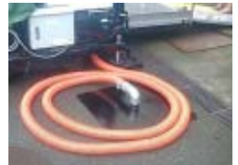
マンホールへの接続
